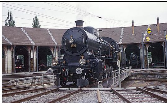
La rotonde de Delémont abrite des véhicules ferroviaires et d'autres objets du temps passé. Cliché CFF Historic
